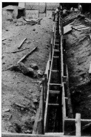
写真-2 型枠の組立て
