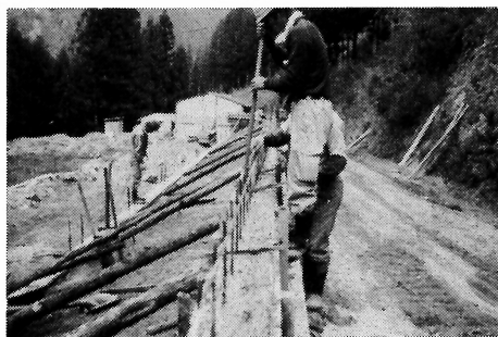
写真-3 コンクリートの打設
