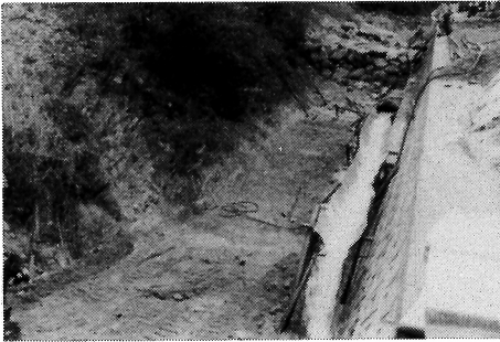
写真-3 量水堰堤基礎の床掘り
