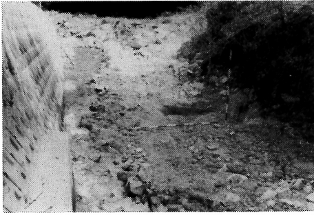
写真-1 量水堰堤建設地点 (上流側から)
