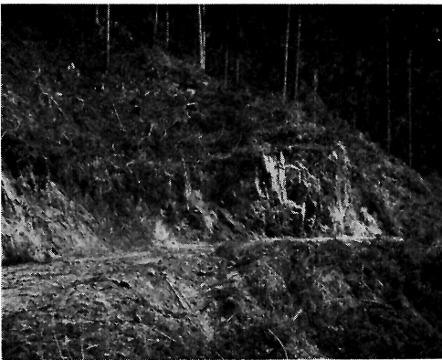
松皮田林道延長工事竣工後の状況(1林班い 小班内の旧造林小屋に至る)。
